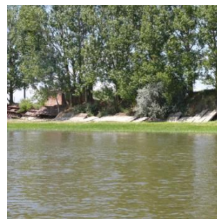
Рисунок 4. Красные Баррикады: а) разрушенный причал, б) размыв берега, в) разрушенное берегоукрепление
