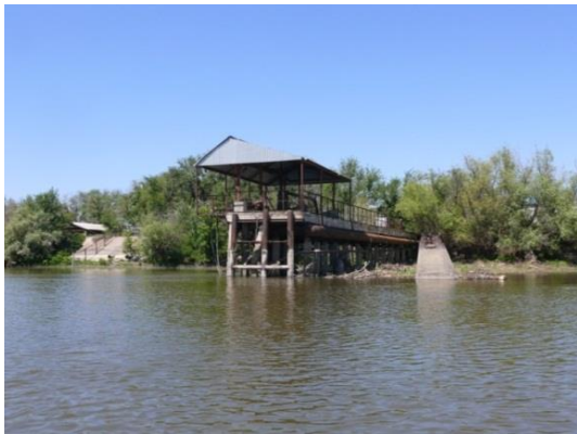
Рисунок 2. Насосная станция, н.п. Красные Баррикады
