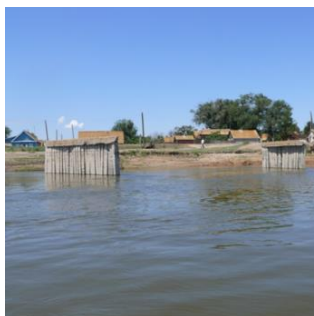
Рисунок 4. Красные Баррикады: а) разрушенный причал, б) размыв берега, в) разрушенное берегоукрепление
