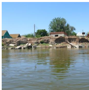
Рисунок 4. Красные Баррикады: а) разрушенный причал, б) размыв берега, в) разрушенное берегоукрепление
