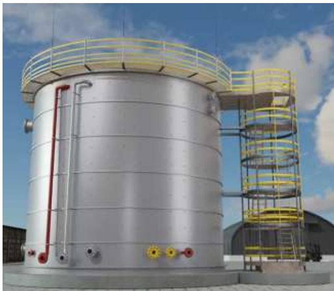
Рисунок. 1. Бак-аккумулятор горячей воды.
