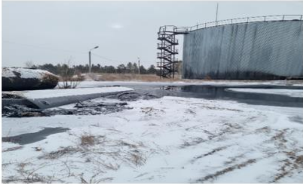
Фото 1. Разлив мазута из резервуара
