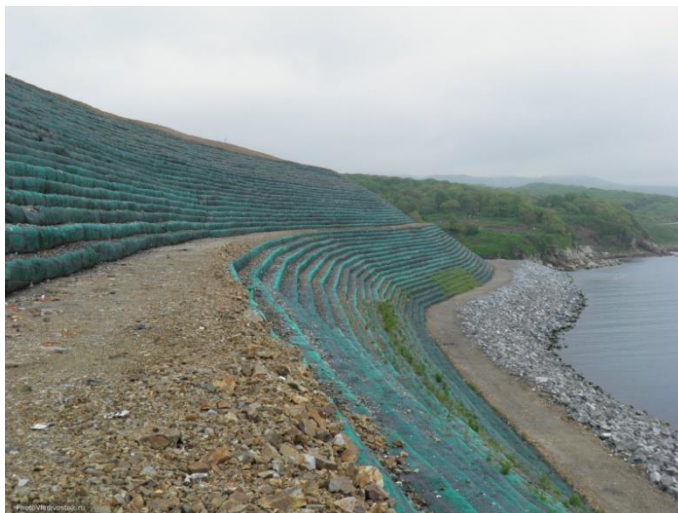
Рис.3. Свалка ТБО «Горностай» после рекультивации
