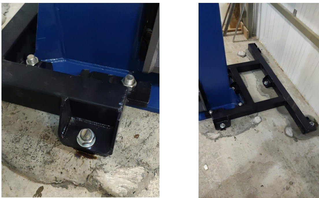
Рис.4 – Анкерные соединения
