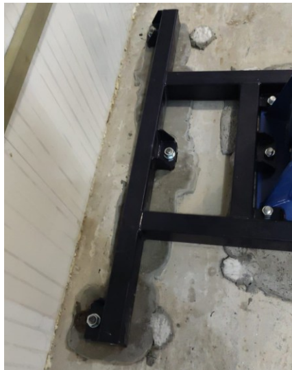
Рис.2 – Сварная сборная металлоконструкция
