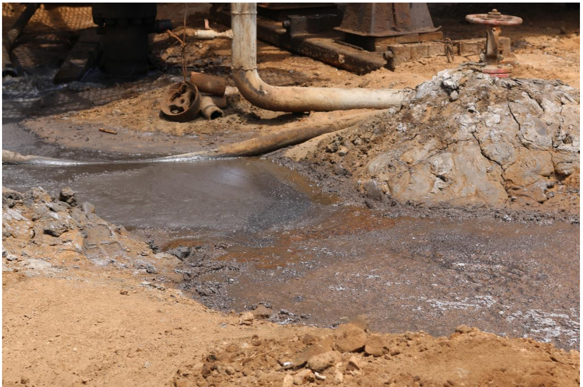
Фото 6. Сброс технической воды со скважин в почву, фото Сангаджиева М.М.
