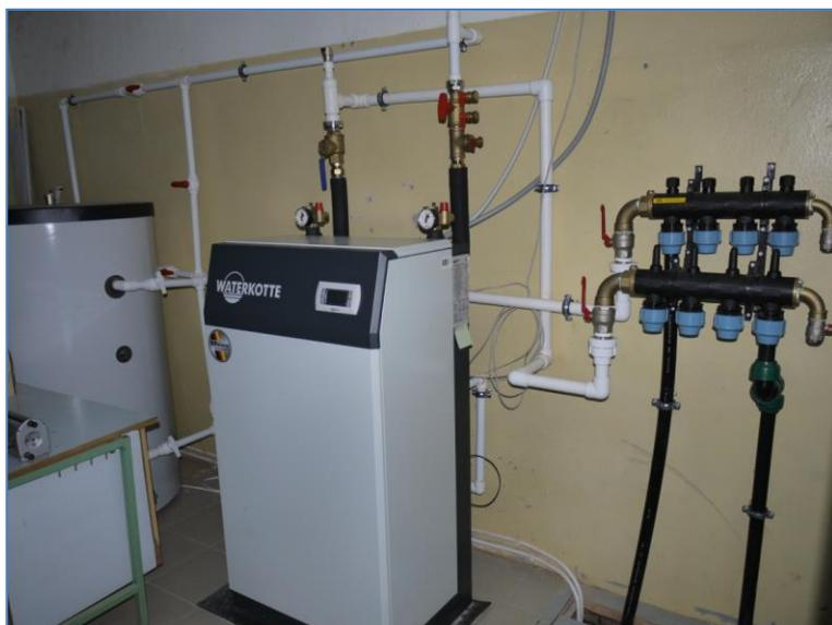
Рисунок 1. Расположение основных элементов теплонасосной системы: ТН «Waterkotte»; бак-накопитель; гребёнка раздаточного коллектора.
