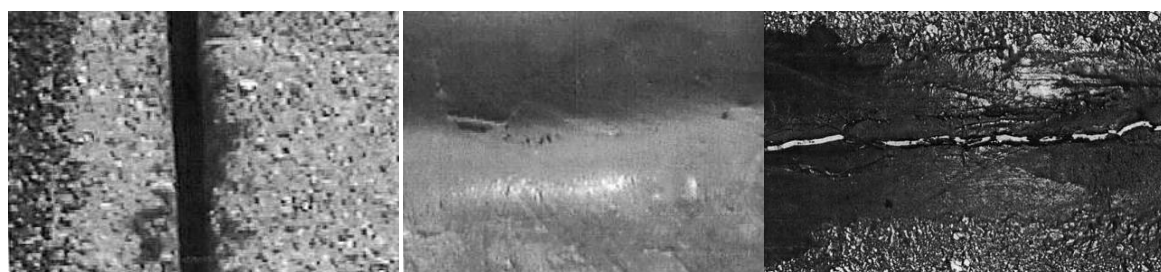
Отсутствие герметика в шве
