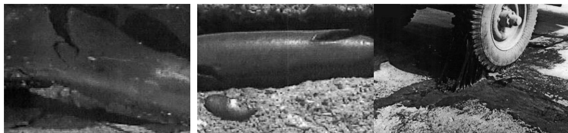
Нарушение адгезии герметика с бетоном
