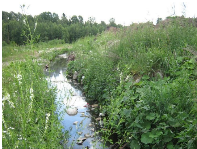
Рисунок 1.2.5. Обводная канава на СВ оконечности полигона Куньголово, (т. 3 на рис. 3, вид на ЮВ). Видна её переполненность фильтратом и намечающийся перелив налево (в «Мёртвое оз.»).
