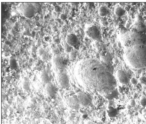
Рисунок 5.6. Язвенная коррозия наружной поверхности стенки трубы
