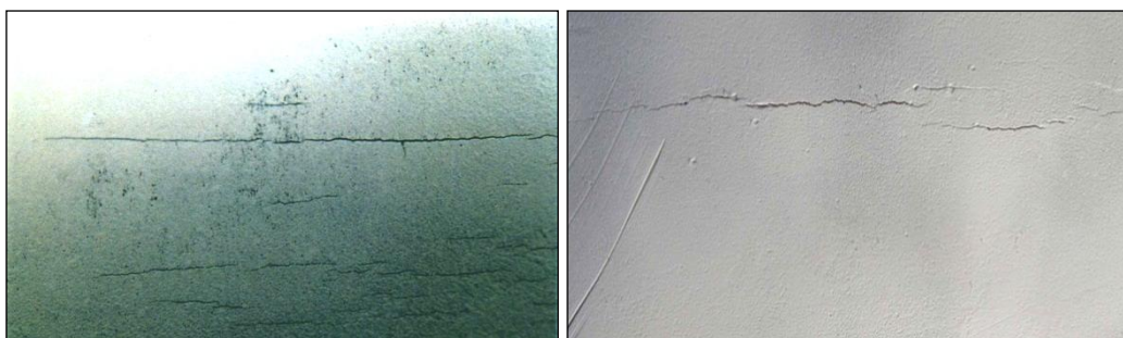
Рисунок 5.3. Дефект КРН с четко выраженной отдельной трещиной
