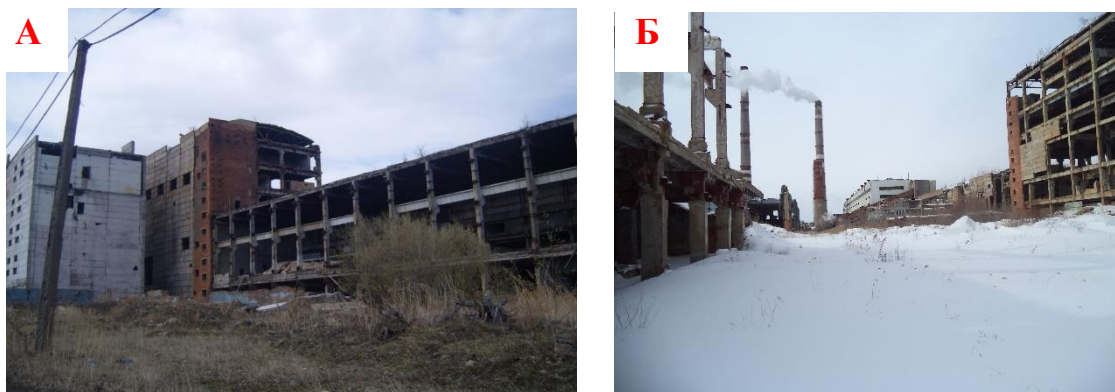
Рисунок 1. Вид разрушенных корпусов ЦКК Примечание – сентябрь, 2008 г. (А) март 2018 г. (Б)
