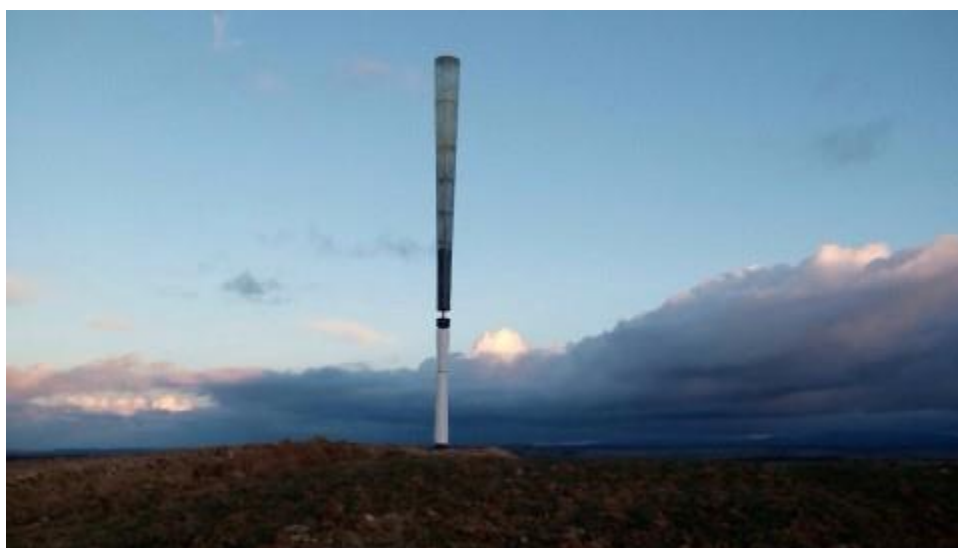
Рисунок 4. Ветрогенератор без лопастей VortexBladeless
