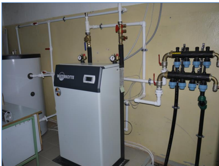
Рисунок 1. Расположение основных элементов теплонасосной системы: ТН «Waterkotte»; бак-накопитель; гребёнка раздаточного коллектора.
