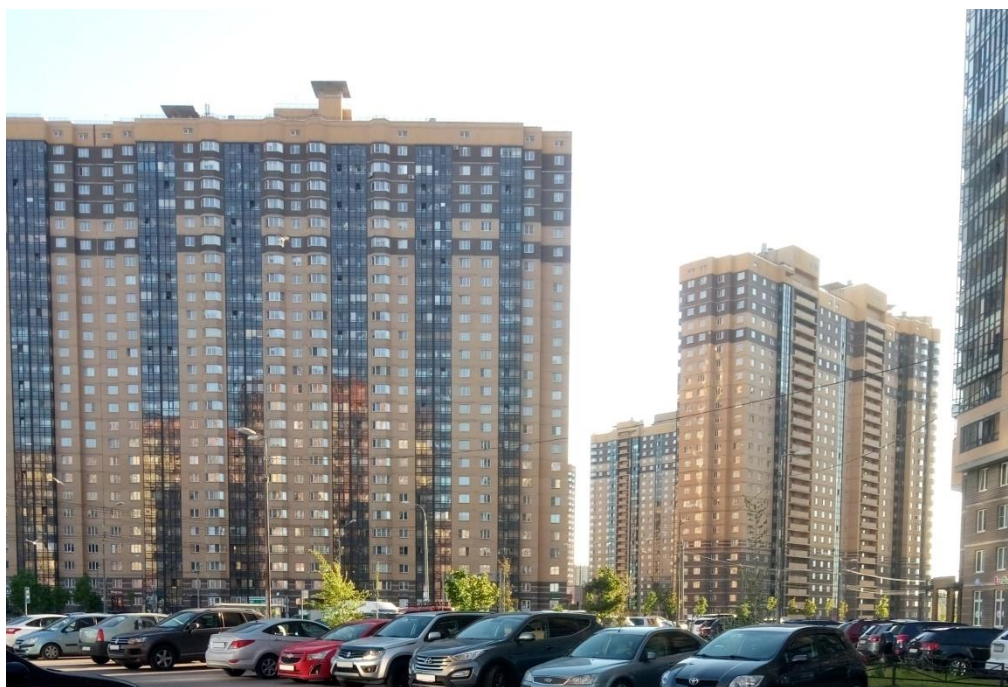
Рисунок 2. Внешний вид фасадов жилых домов жилого комплекса «Северная долина».
