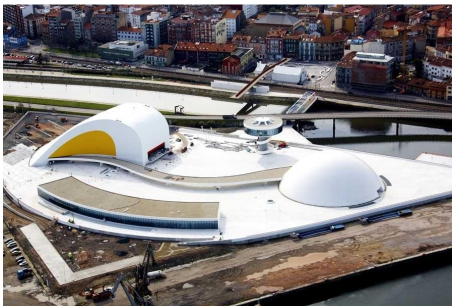
Рисунок 7. Строительство Культурного центра.
