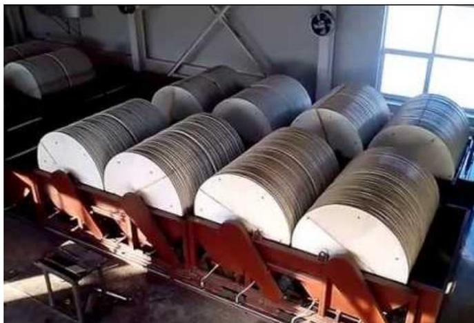
Рис. 10. Биофильтр с дисковой загрузкой
