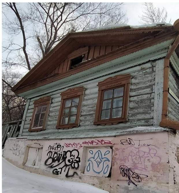
Рис. 2. Здание 1928 года постройки, подлежащее сносу
