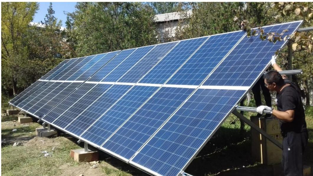
Рисунок 5.11. Общий вид исследуемой автономной ФЭС с номинальной мощностью 5 кВт при Кыргызско-Узбекском университете.
