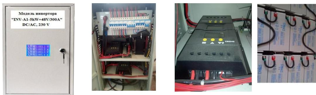
Рисунок 5.13. Общий вид инвертора, размещение контроллера заряда, автомата управления и соединения аккумуляторных батарей в исследуемой автономной ФЭС с номинальной мощностью 5 кВт.
