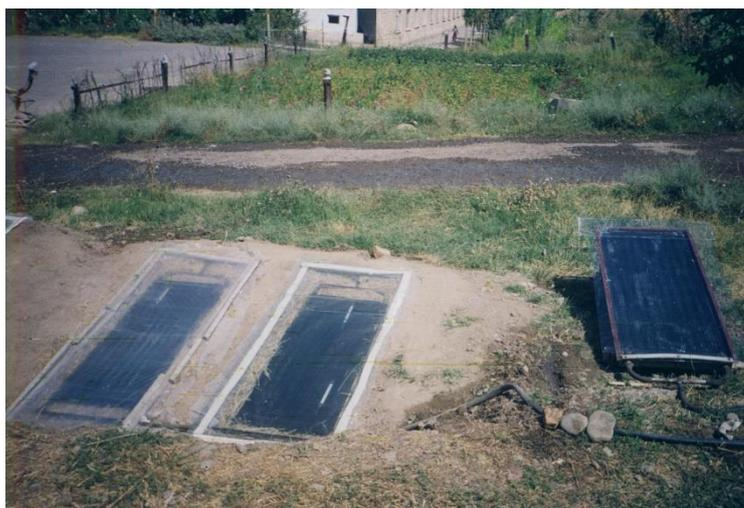
Рисунок 3.2. Общий вид грунтового солнечного водонагревательного коллектора.
