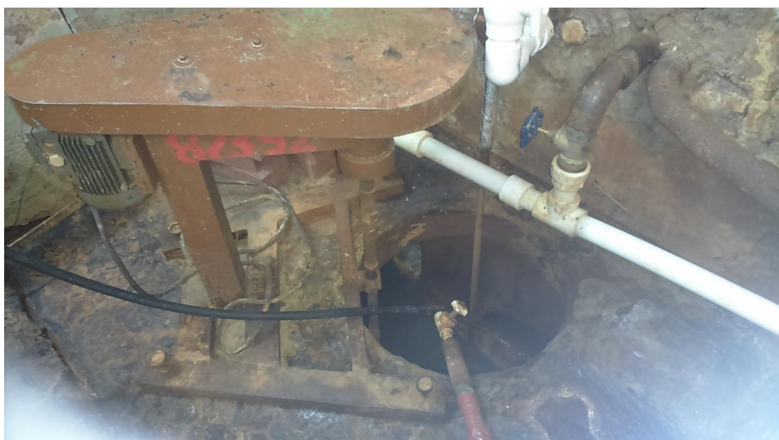
Рисунок 3.2. Действующие очистные сооружения гальванического производства 2
