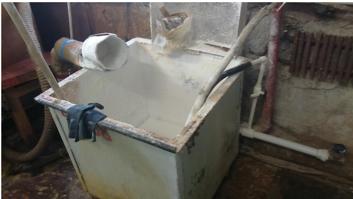
Рисунок 3.1. Действующие очистные сооружения гальванического производства 1
