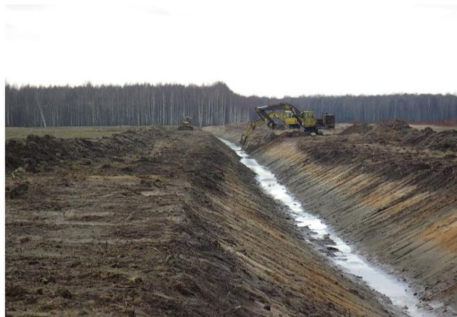
Рисунок 2. Очищенный канал с закрепленным дном.
