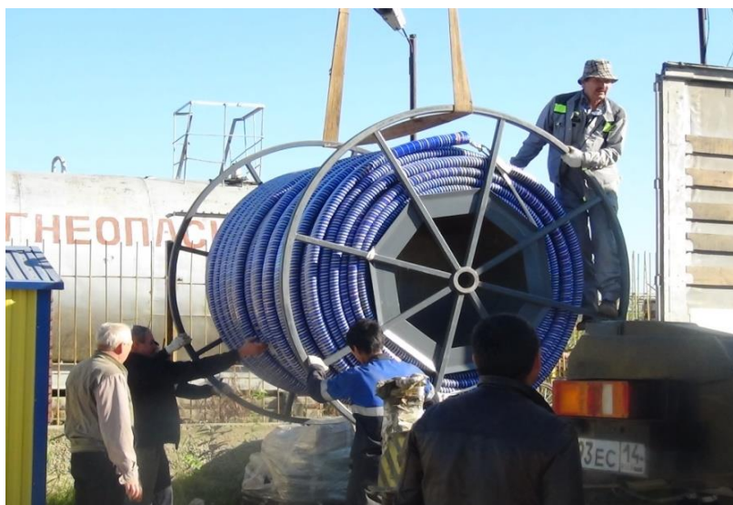
Рисунок 1. Доставка труб «Primus Line» на строительную площадку, г.Якутск
