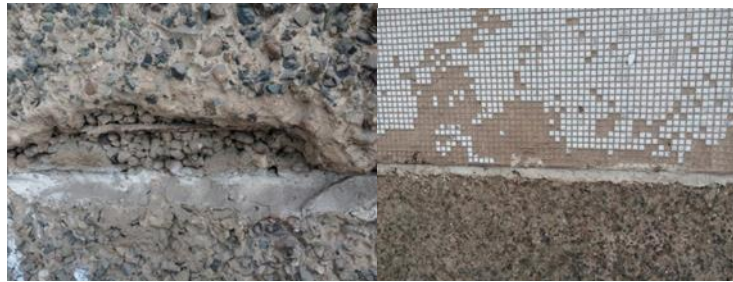
Рисунок 1. Разрушение фасада панельного жилого дома (97 серия)
