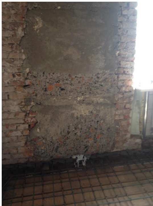
Рисунок 6. Обработка сердечников теплоизоляционной краской «Корунд»
