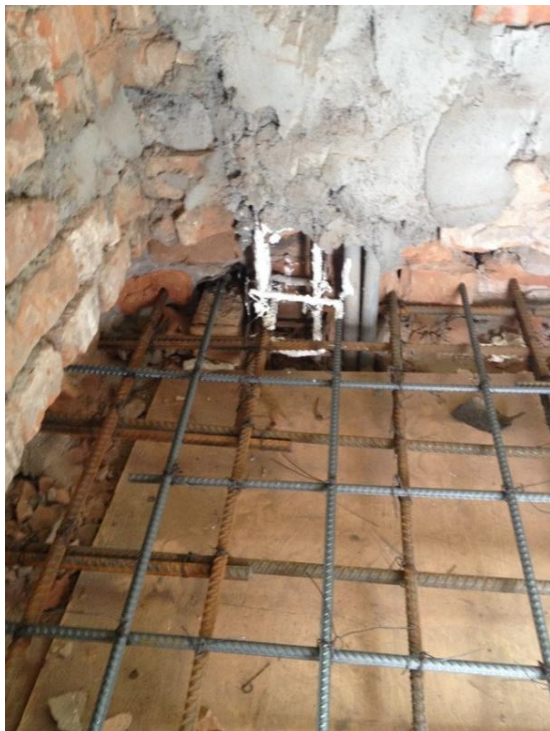
Рисунок 6. Обработка сердечников теплоизоляционной краской «Корунд»
