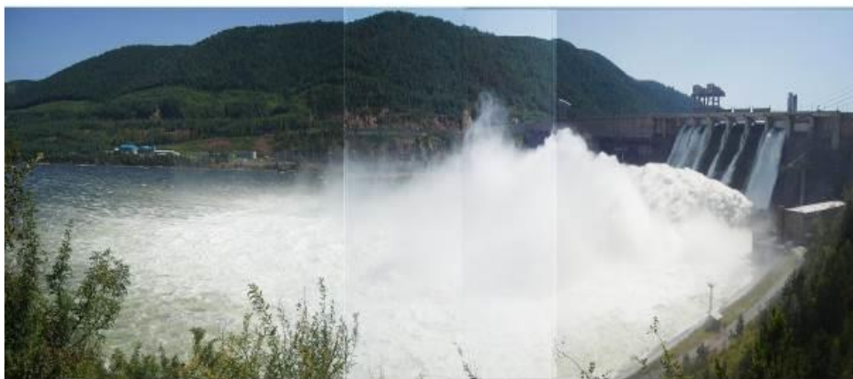
Рисунок 8. Сброс воды через плотину Красноярского вдхр в 2006 г. Высота плотины более 100 м
